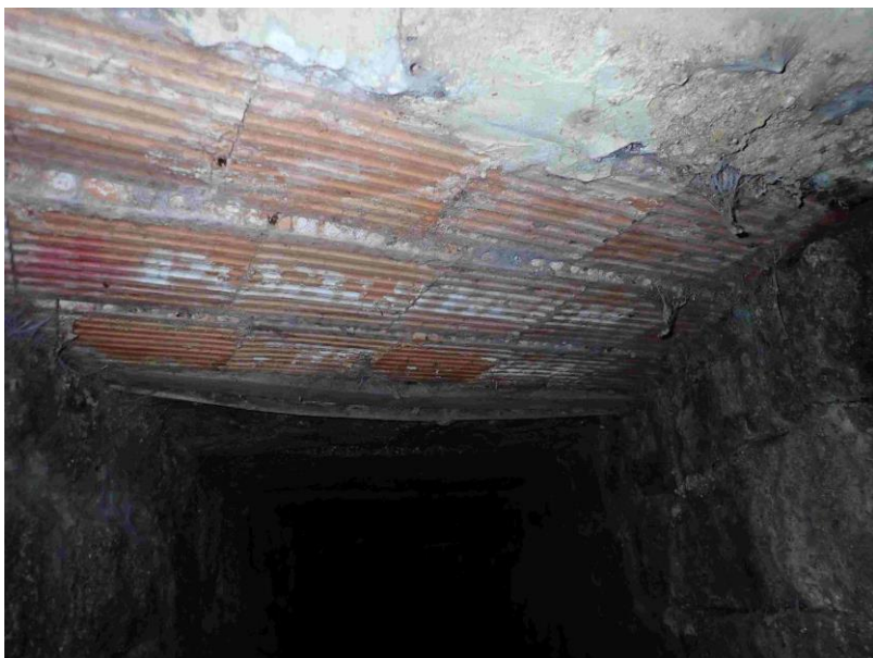
Podhled nosné konstrukce v místě opravy ze ztraceného bednění
