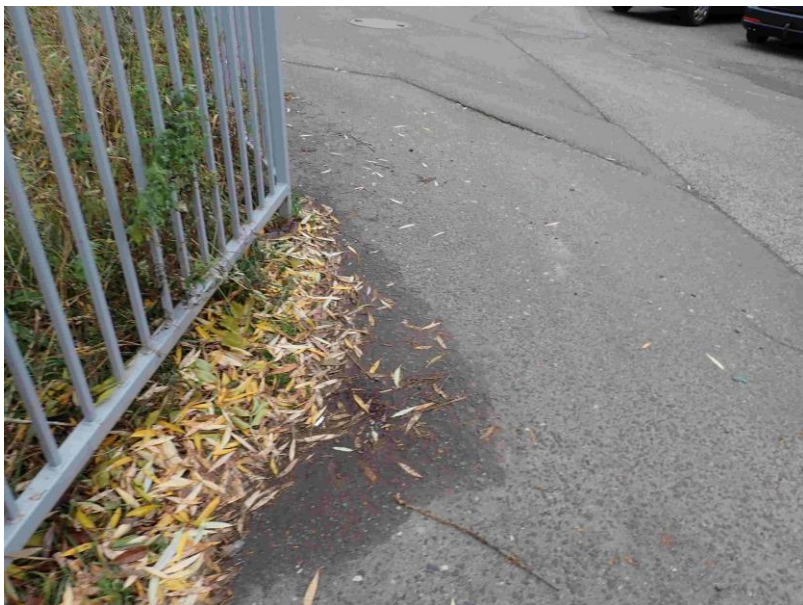
Povrch vozovky na vtoku
