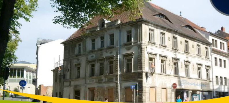
Ehem. Fischhaus Byvalá rybárna
